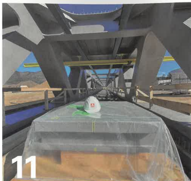
Die Jauntalbrücke über die Drau: Huckepack wurden die SIP-Gleitpendella-ger mit dem Tragwerksvorschub zu den Pfeilern verfrachtet. Foto: Maurer SE
