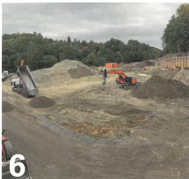
Das Freilichtmuseum Detmold wird aktuell mit dem DGNB Zertifikat „nachhaltige Baustelle Spezialtiefbau“ ausgezeichnet. Foto: Harald Gollwitzer
