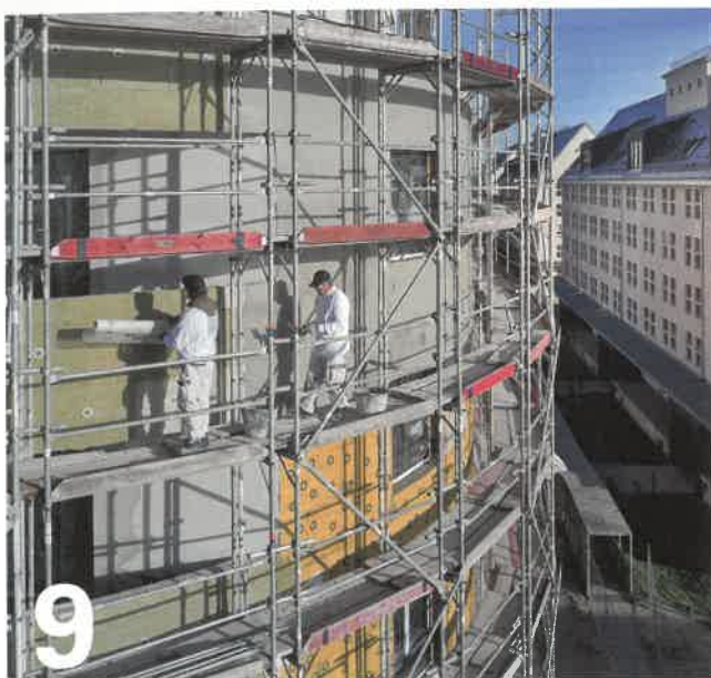
Das Wohnquartier Speicherballert der Buwog in Berlin Spandau wurde mit einem sortenrein trennbaren WDVS errichtet. Foto: Saint Gobain Weber
