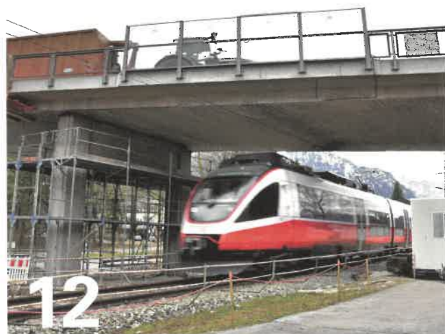
Die Brücke in Bad Reichenhall konnte mit eingeklebten Betonschrauben bei laufendem Verkehr verstärkt werden. Foto: Würth
